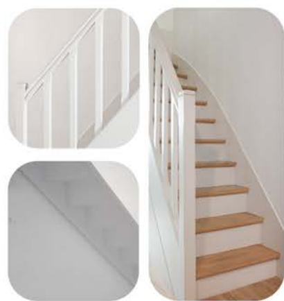
Peindre l'ensemble de l'escalier en blanc laisser les plates marches en bois vernis
